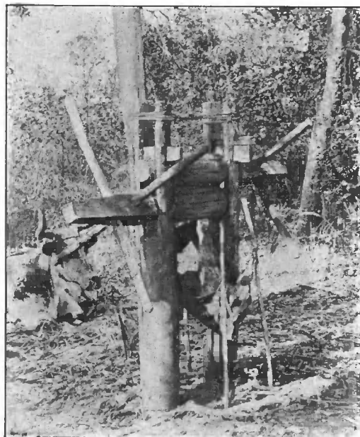
Рис. 18. Прimitивная машина для выжиманія сока сахарнаго тростника.
